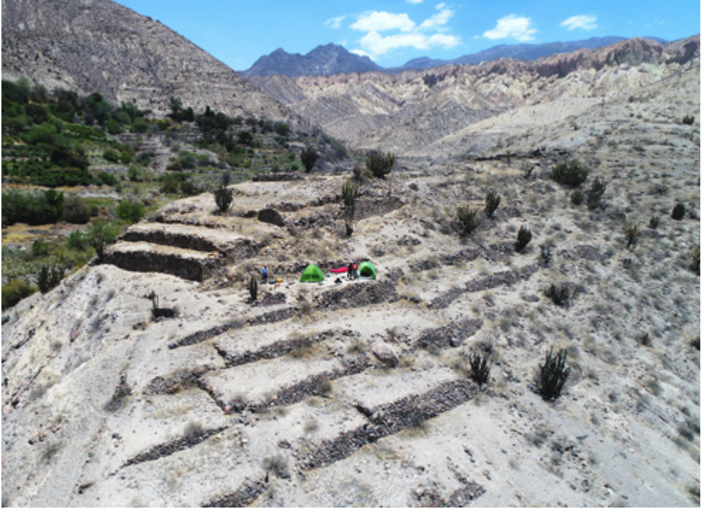
■ Vista panorámica de los andenes del pueblo incaico de Estagagache cubiertos por piroclastos de la erupción del año 1600 (Foto: Ingemmet)
