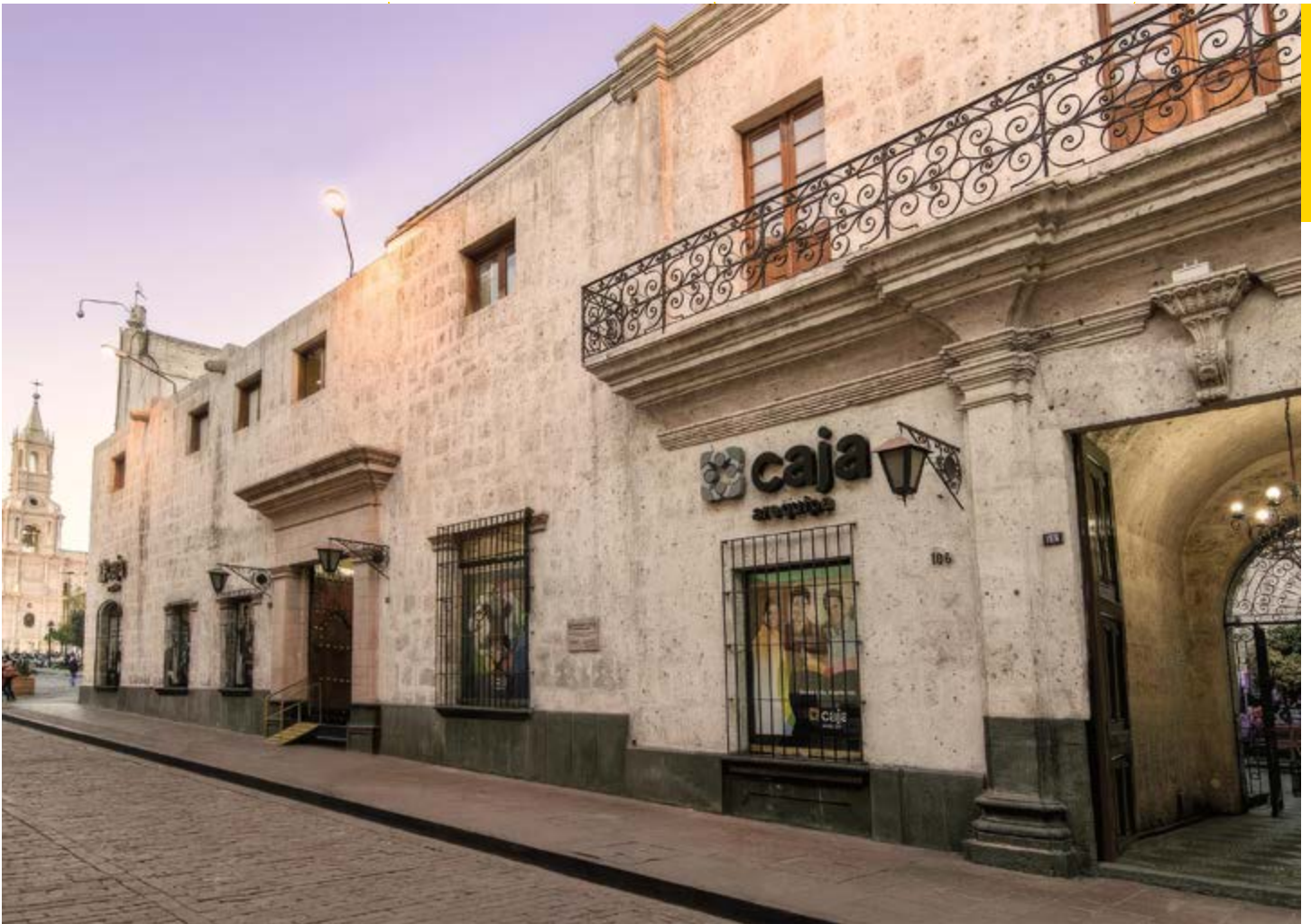
Vista exterior de la sede de Caja Arequipa en el centro histórico de Arequipa.
