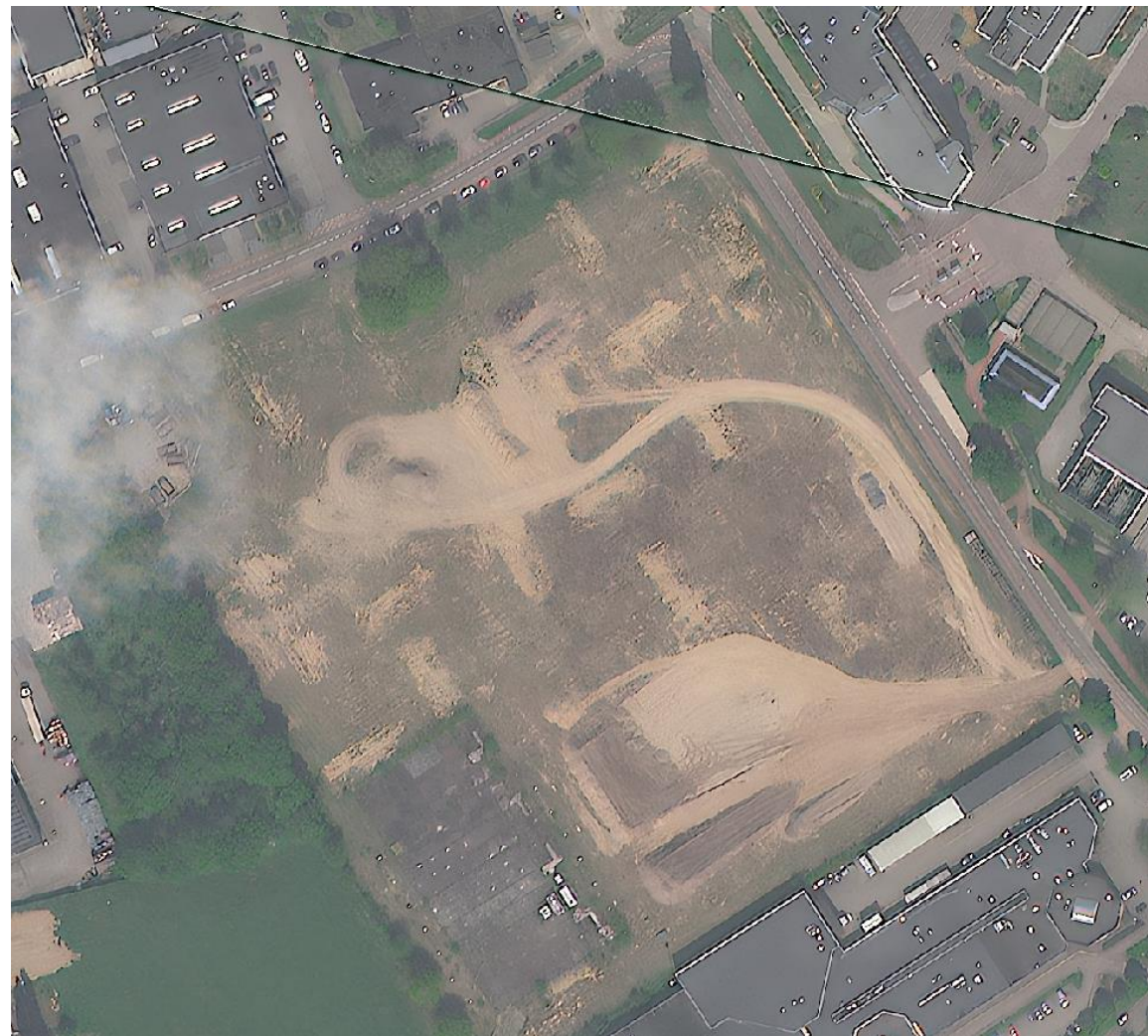
Pre-constructie landontruiming – april 2024
