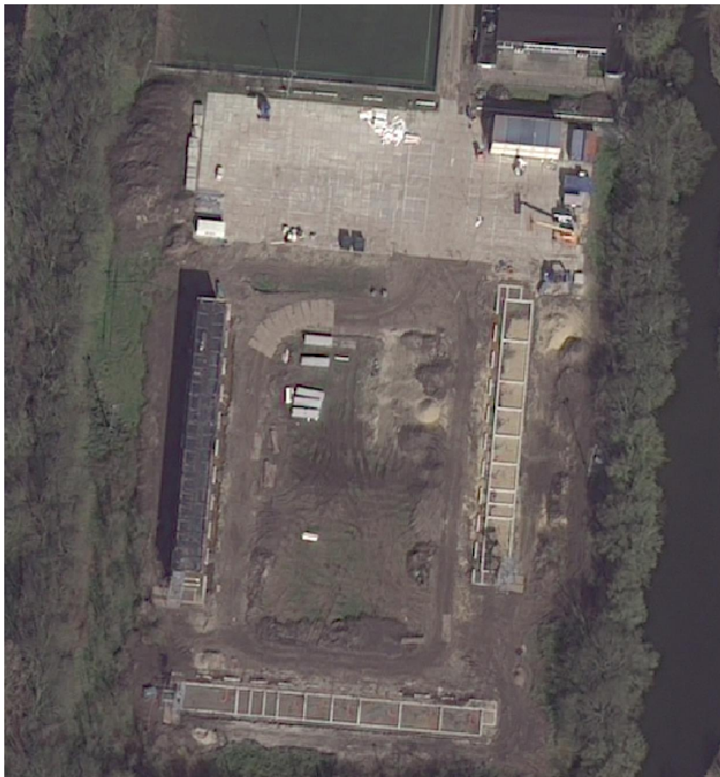
Pre-constructie – 1 gebouw + bouwkantoor
